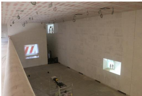
La « white box » en travaux...
