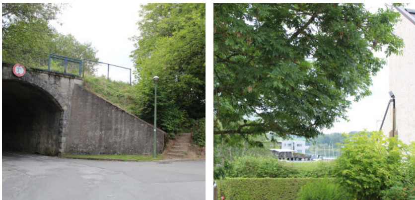
Vocabulaire routier, pas de trottoir, vues bouchées.
