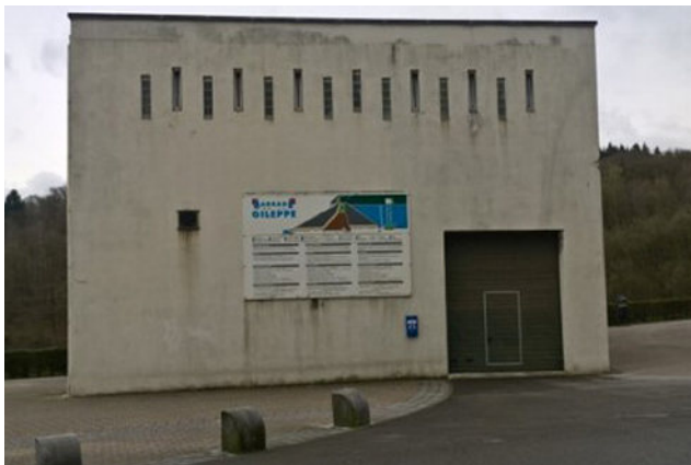
Bloc accueil d'accès à l'intérieur du barrage
