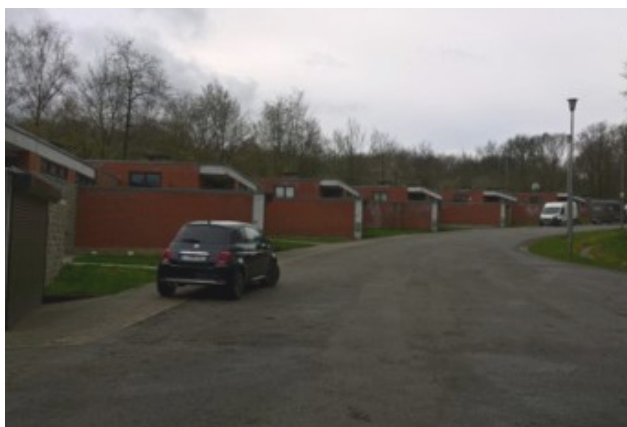
Maisons des barragistes
