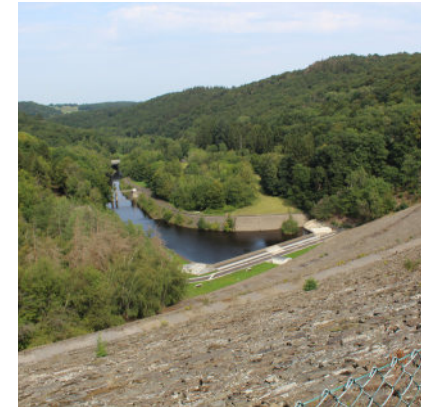
Installations techniques en contrebas et tête d'aqueduc
