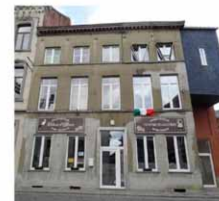
• Adaptation des enseignes à la charte • Ravalement de façades • Remplacement des châssis du rez en harmonie avec le caractère ancien
