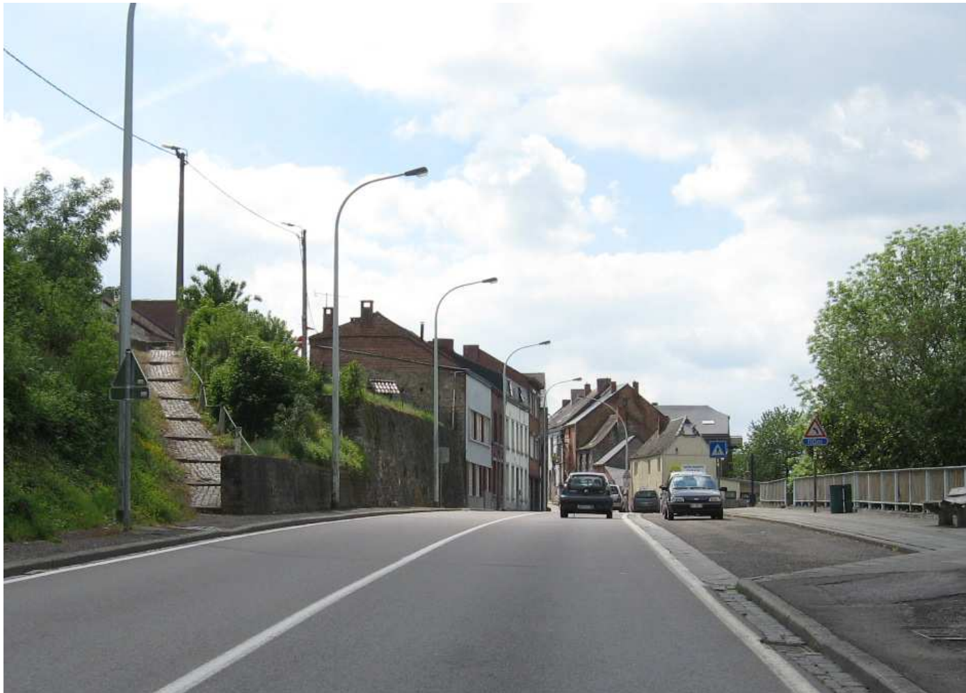
Rue de Binche / Avant :
