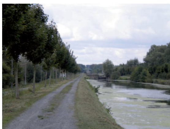
Figure 6 : Chemin de halage le long de l'ancien canal (Source : JNC-AWP)
