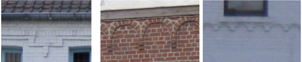
Figure 7: Exemples de frise en briques présents à Bernissart (Source: JNC-AWP)
