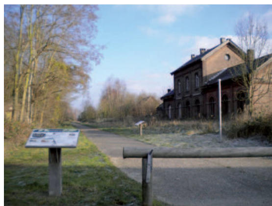
Figure 2 : Accès au RAVeL au niveau de l'ancienne gare (Source: JNC-AWP)
