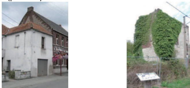
Figure 8: Bâti concerné par un manque d'entretien (Source: JNC-AWP)
