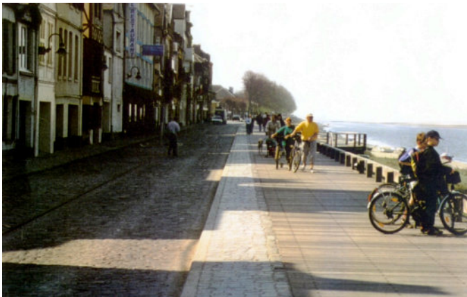
Estacade à Saint-Valéry sur Somme (JNC)
