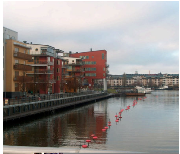
Estacade à Stockolm, appontement pour bateau en contrebas
