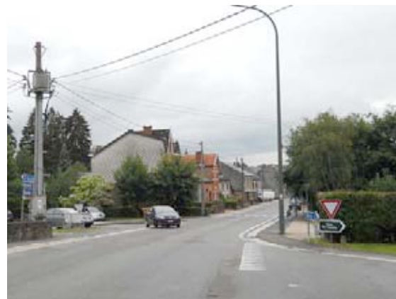
3. Rue Emile Parfonry - Entrée de ville ressentie Lg voirie: 6m20 pour +/-5m40 d'accotements
