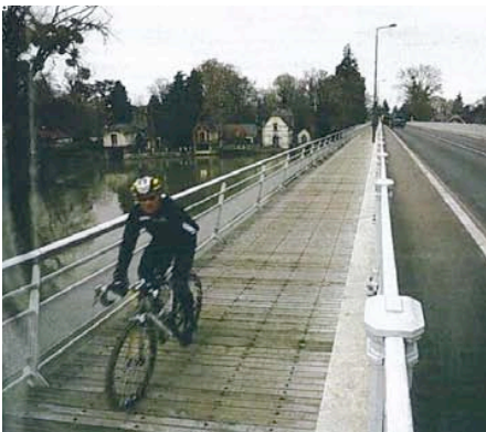
Passerelle suspendue sur un pont à Orléans
