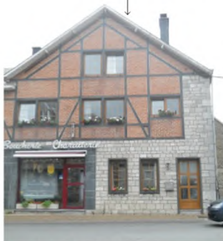
Rue des Ecoles - Façades Est
