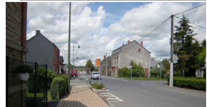
5. Croisement Rue Rouge-Croix et rue du Levant - entrée de ville ressentie Lg voirie: 7m15 pour +/-5m15 d'accotements
