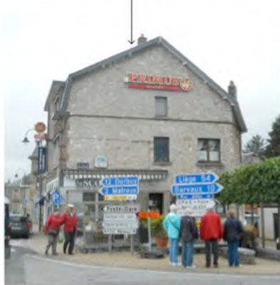
Rue des Ecoles - Façades Ouest - Place Saint-Nicolas
