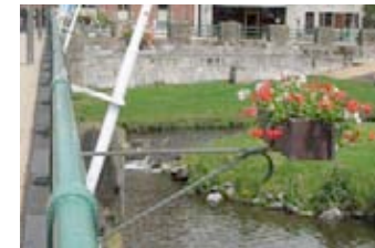
Pont - rue des Ecoles
