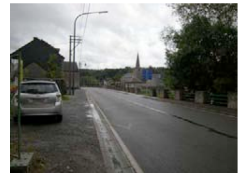
3. Rue de la Vallée vers le Centre Lg voirie: 7m30 pour +/-3m60 d'accotements
