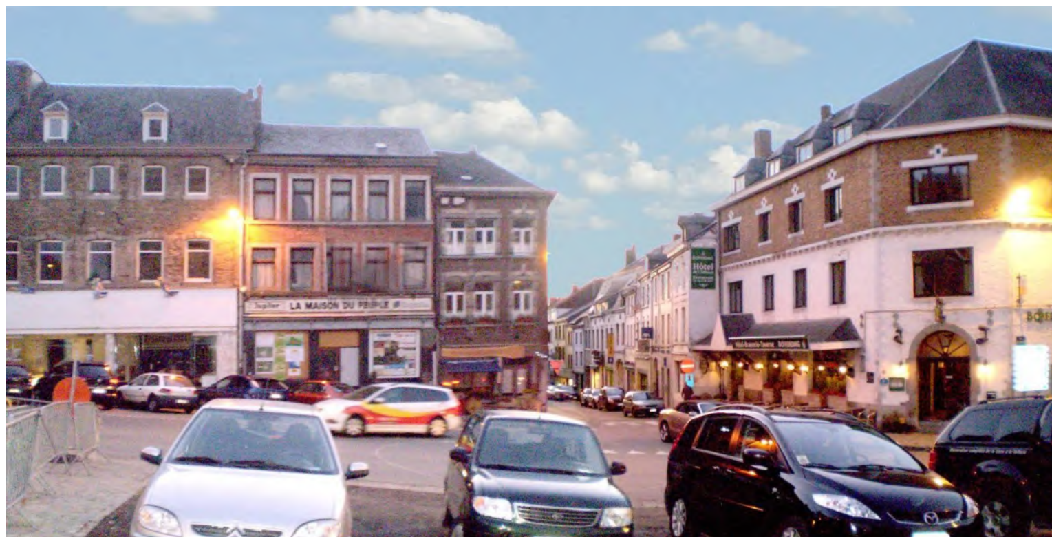
Situation actuelle (photo prise pendant la fin des travaux de réhabilitation de la place par la Province).
