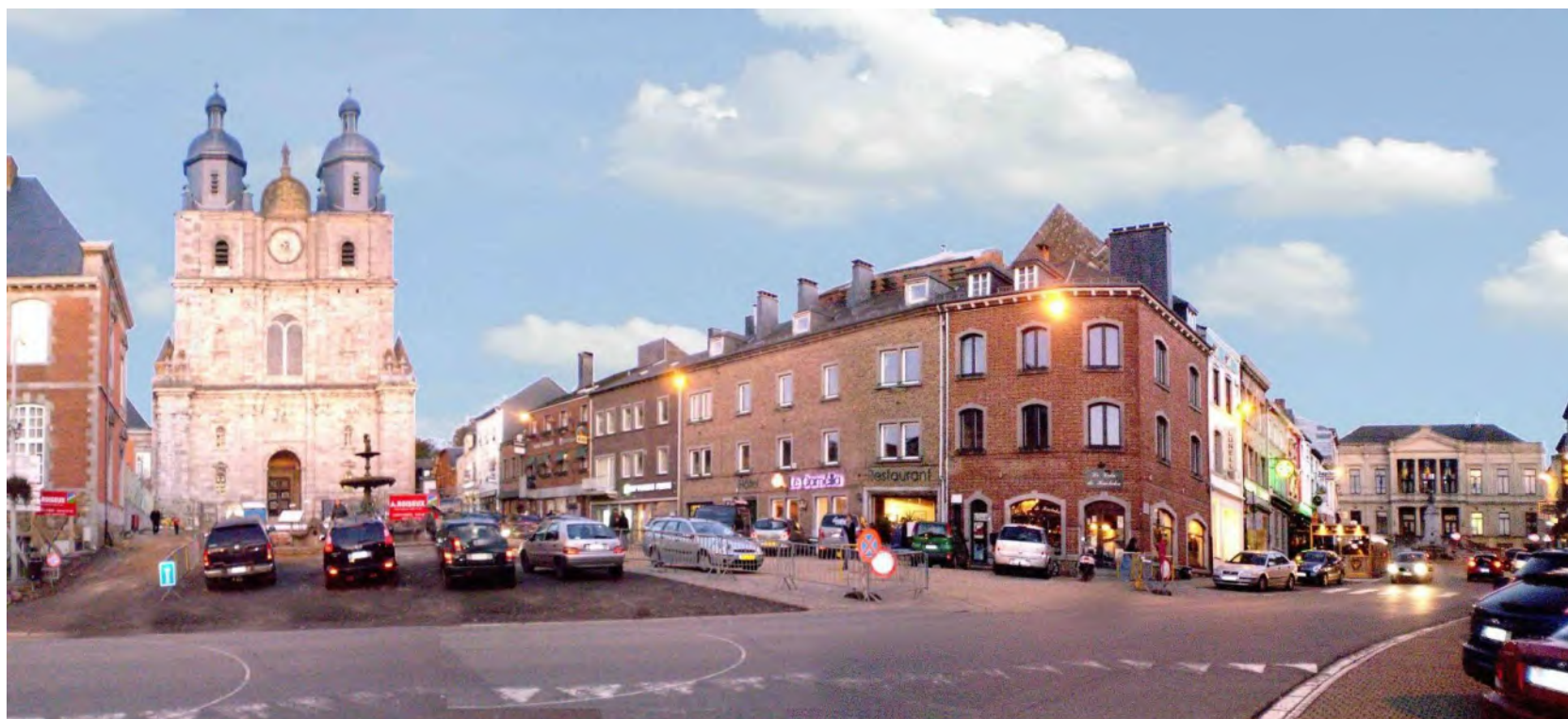
Situation actuelle (photo prise durant la fin des travaux de réhabilitation de la place par la Province).
