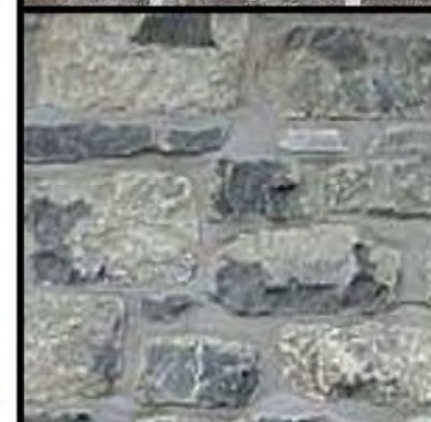
Moellons de pierre bleue
