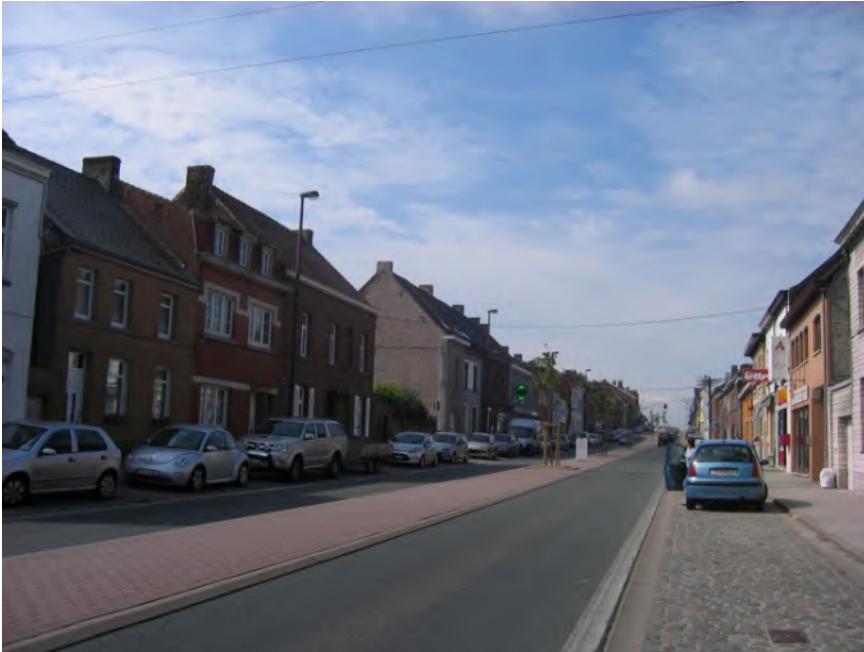
Exemple de stationnement en pavés le long de la voirie à Lillois
