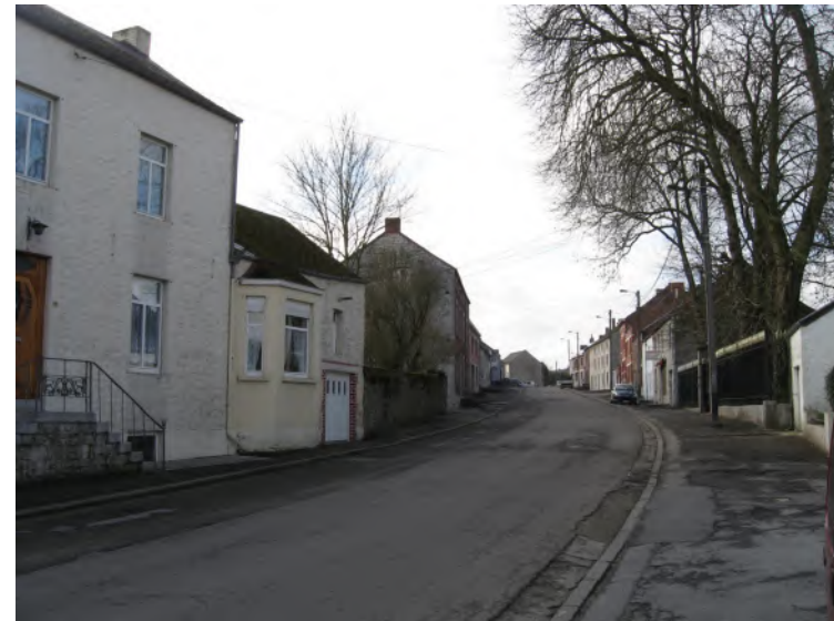
Photo de la situation existante (Rue au-delà de l'Eau)
