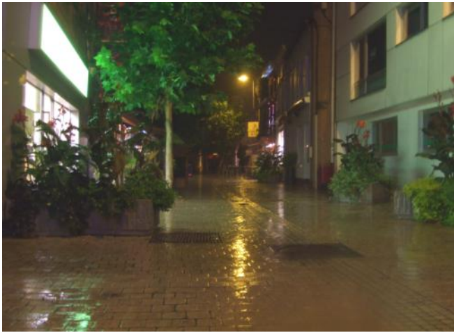
Rue Charles Sambon : situation existante
