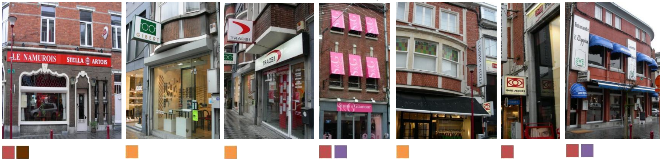
Enseigne drapeau : caisson lumineux non autorisé
