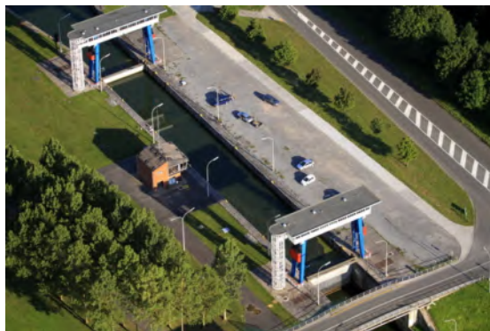
écluse à relevage ou "à guillotine" (Source : louisvandeskelde.biz)
